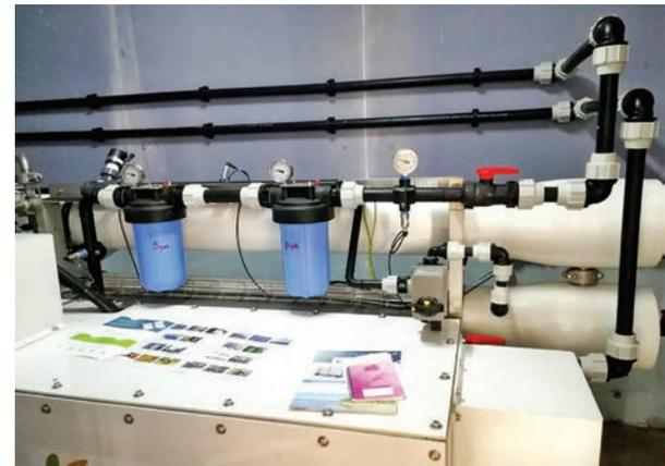
Les deux turbines et le filtre nécessaires au système de l'osmose inverse
